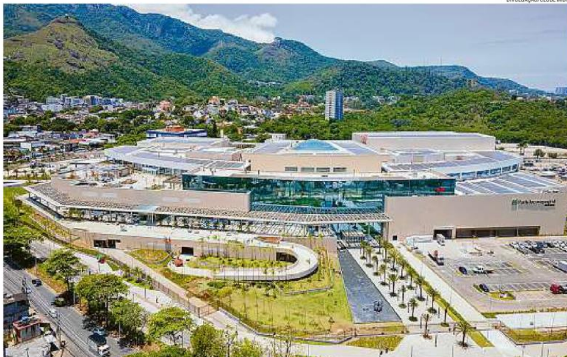
Park Jacarepaguá. A fachada do shopping e parte do estacionamento passam pelos ajustes finais antes da inauguração para convidados quinta-feira
